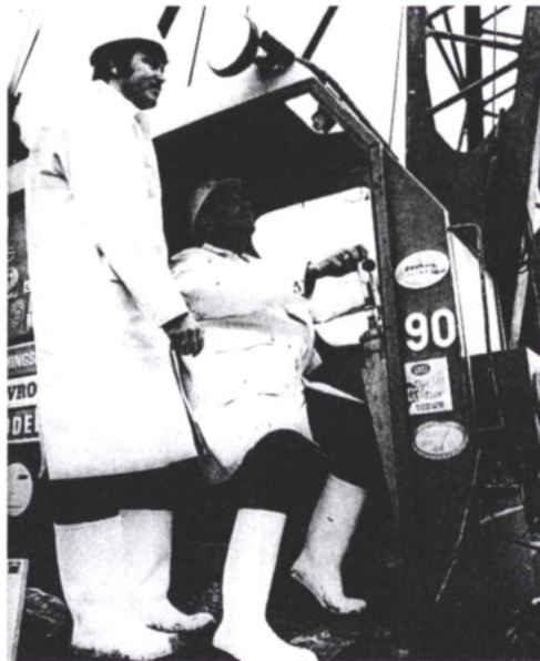
Het oudste en jongste personeelslid van het korps, de heren Altena en Bol, heien de eerste paal voor het nieuwe buro aan de Blokmergouww op 11 oktober 1979 de grond in.
