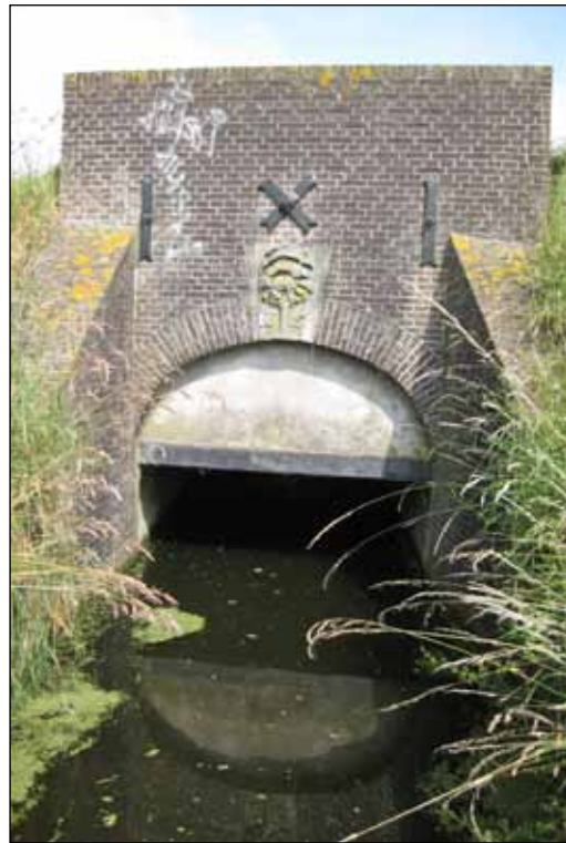
Afb. 9.18 De Kathammer uitwateringssluit uit de 17 de eeuw.
