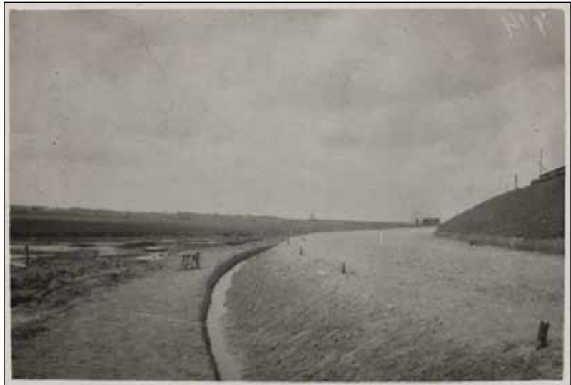
Afb. 8.23 Tijdens de dijkversterking na 1916 is langs grote delen van de dijk een steunberm aangelegd. Op de foto is de situatie ter plekke van d Etersheimerbraak te zien (collectie NHA).
