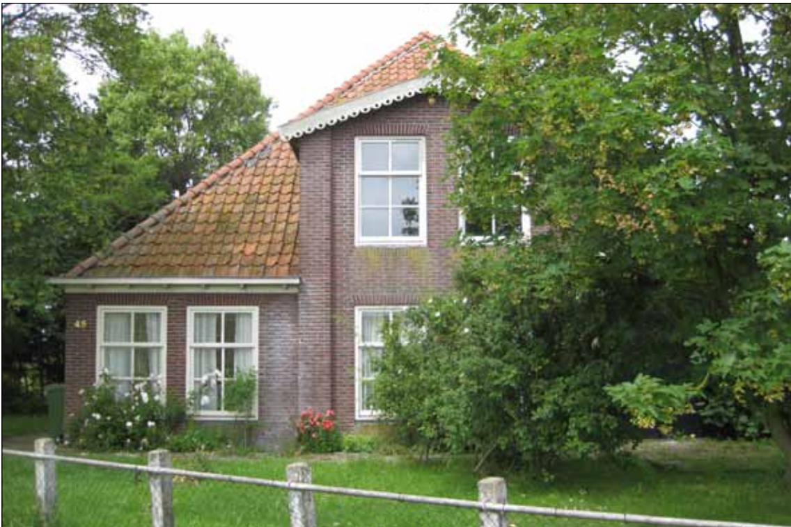
Afb. 9.27 Hoogedijk 45 in Katwoude, een stolpboerderij van rond 1900.
