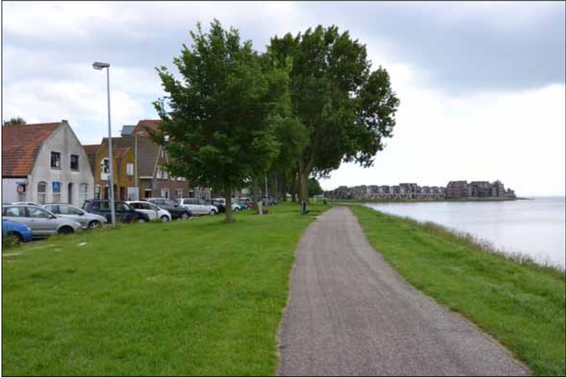
Afb. 9.1 De Westerdijk in Hoorn, gezien richting het zuidoosten.
