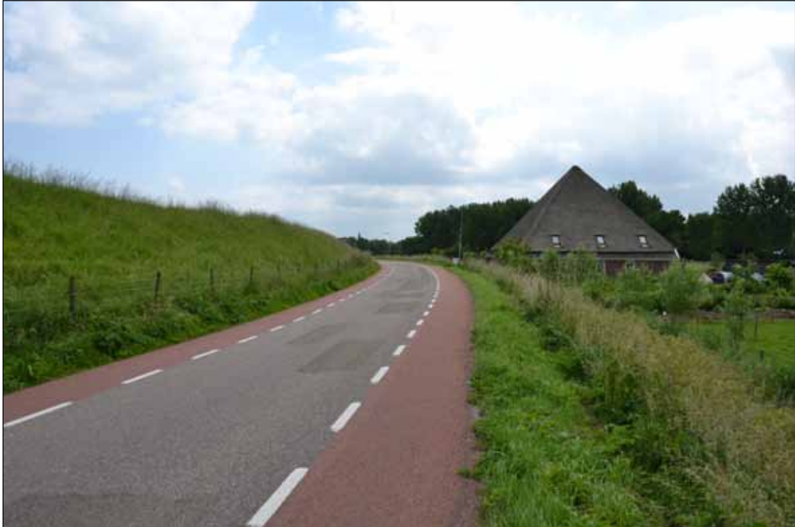
Afb. 9.16 IJsselmeerdijk 6 in Scharwoude: een monumentwaardige stolpboerderij.
