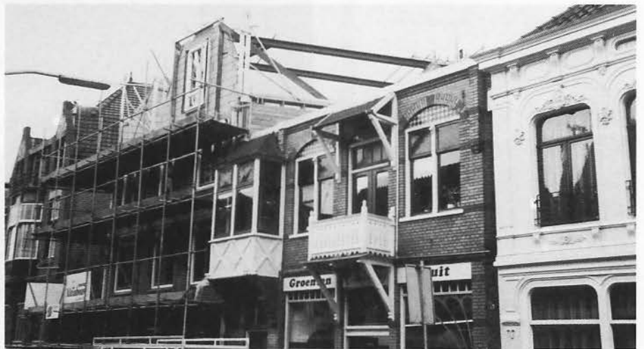
Kleine Noord; nieuwbouw hoek Slijksteeg
