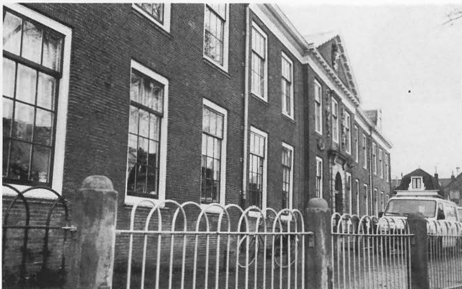
Restauratie hekwerk Dal
