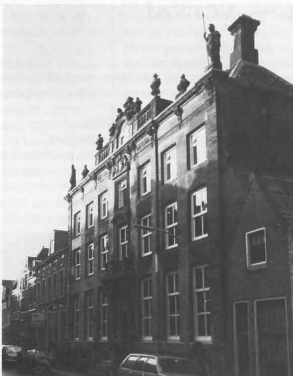
Foreestenhuis na restauratie voorgevel
