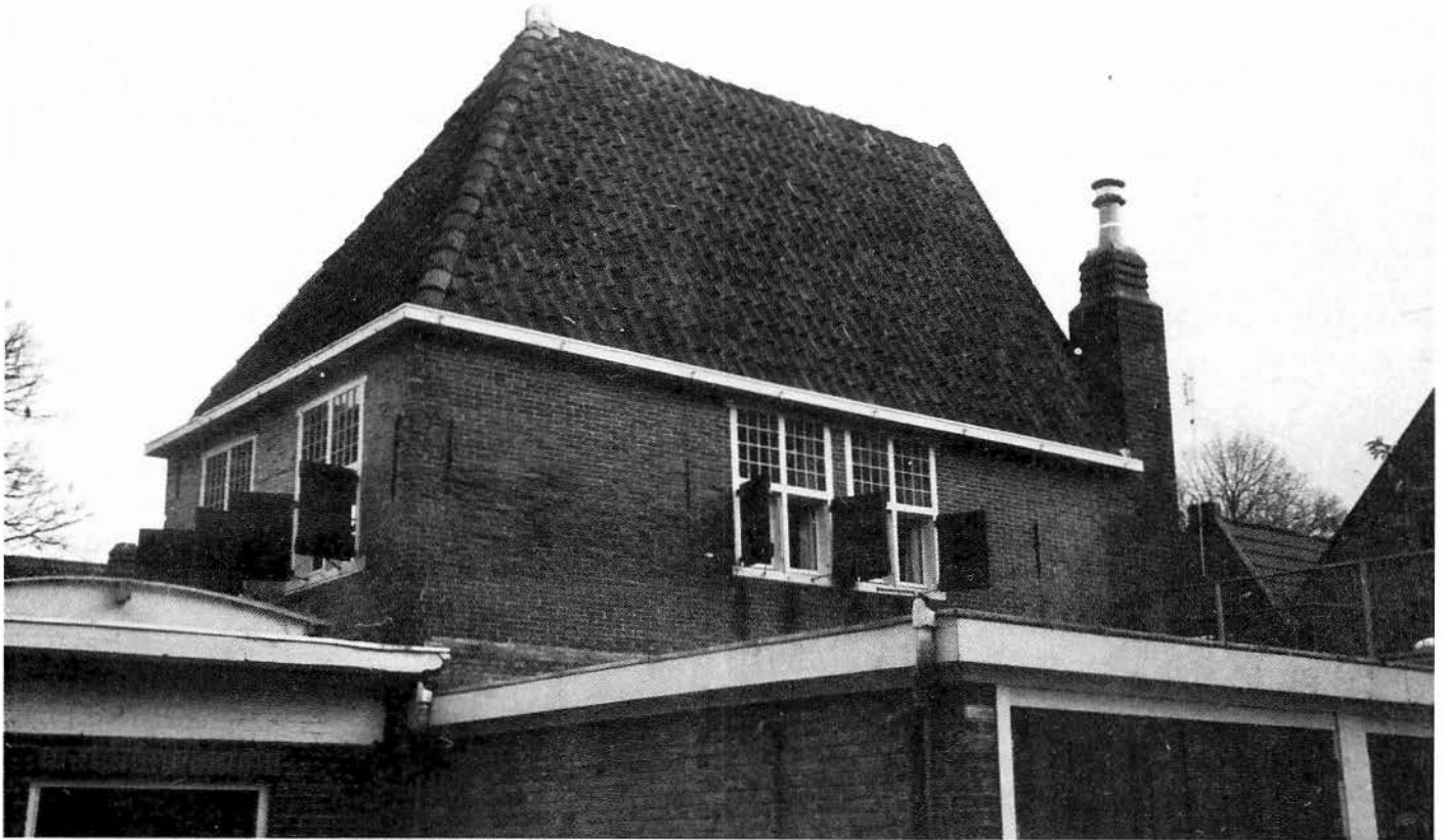
Vanaf de Veemarkt ter hoogte van garage Leeuw is het bovenstuk van het timmermansgildehuisje duidelijk te zien.
