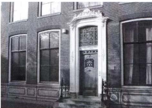
Het pand Grote Oost 53, waar links naast de voordeur de gerestaureerde zittingzaal van het Kantongerecht te vinden is.
