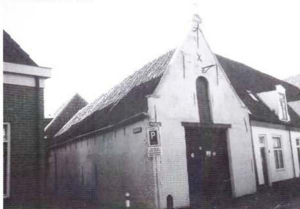
Bedrijfspan, oorspronkelijk uit 1770, in verval.
