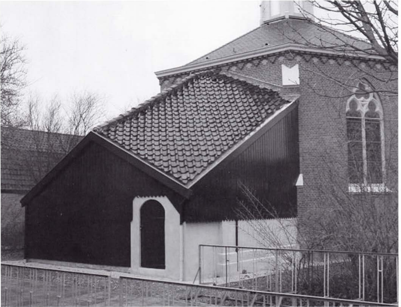
De achterzijde van de Lourdeskapel met de uitbouw waarin de grot is ondergebracht. Achter de deur bevindt zich een kleine ruimte waar, bij gebrek aan een natuurlijke bron als in Lourdes, enkele daartoe aangestelde 'pomper' bij toerbeurt water oppompten om de kraantjes bij de grot van water te voorzien.
