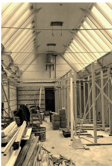
Badhuis Kruisstraat in aanbouw
