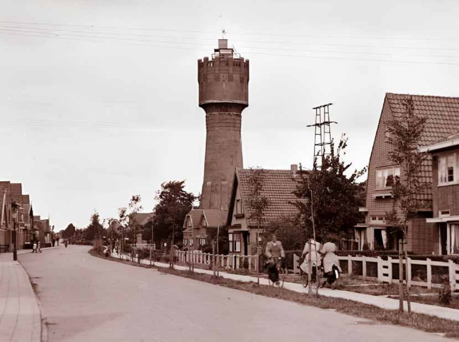
De watertoren aan het Keern
